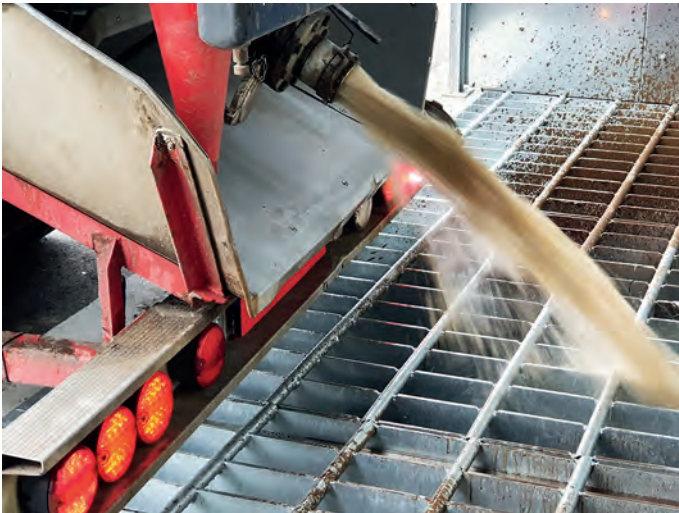
Entleerung Bohrspülung (Flüssigphase) aus Fahrzeug
