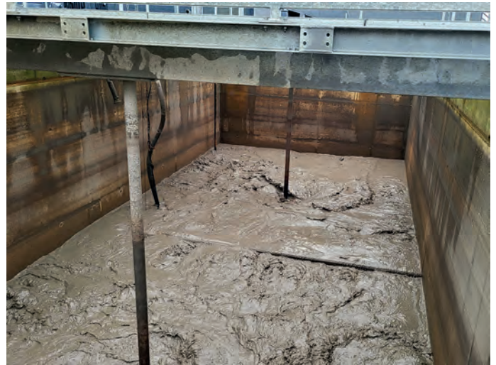
Zwischenpuffer mit Rührwerk
