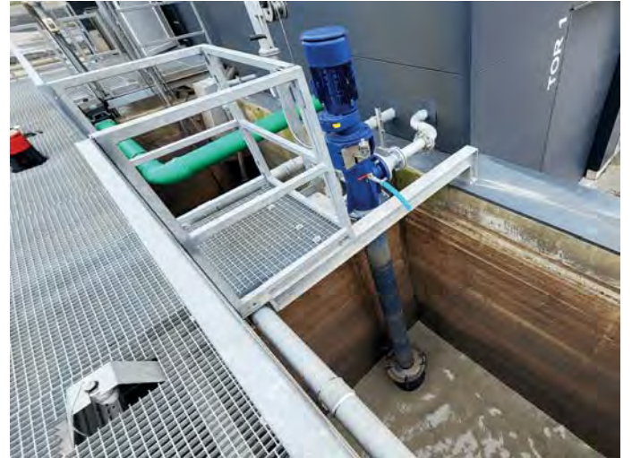
Rührwerksbecken mit Beschickungspumpe Zentrifuge
