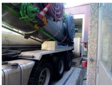
Entleervorgang Saug-/ Spülfahrzeug
