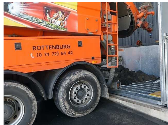
Materialaufgabe durch Kanalreinigungsfahrzeug
